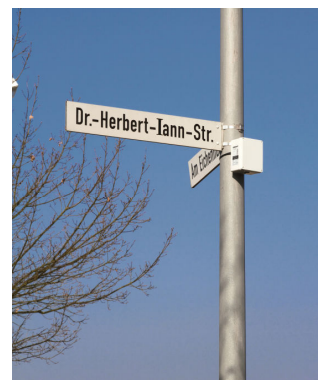
GSM-box na stĺpe osvetlenia
